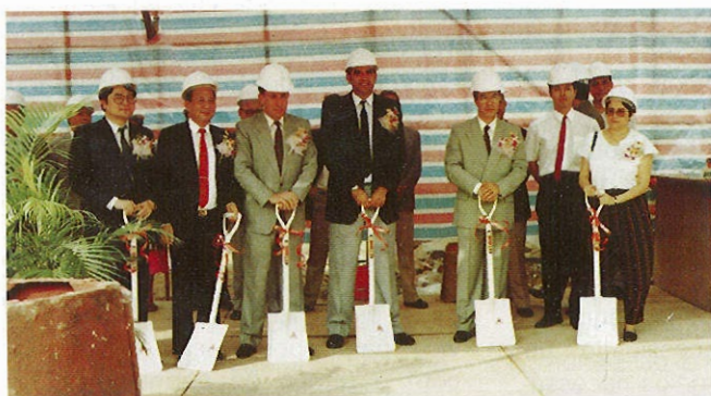
Lançamento da primeira pedra da segunda fase do Edifício da Obra Social da P.S.P. em cerimónia que se realizou no passado dia 4 de Setembro com a presença de ilustres personalidades.
